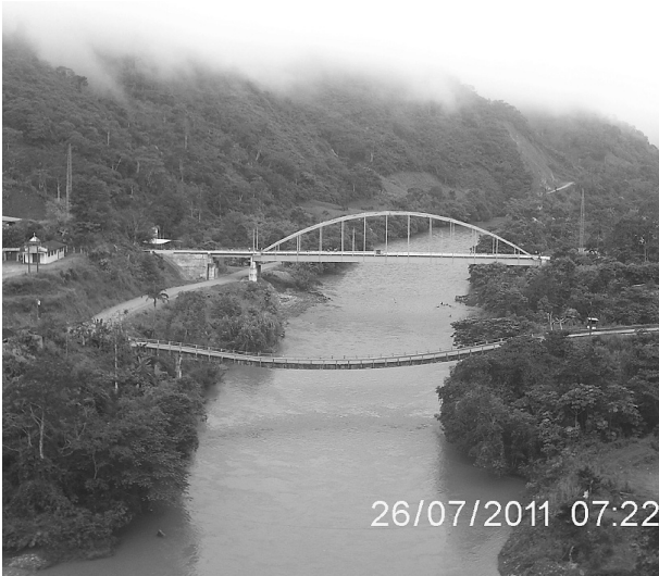
Reconstruido y colocado.
