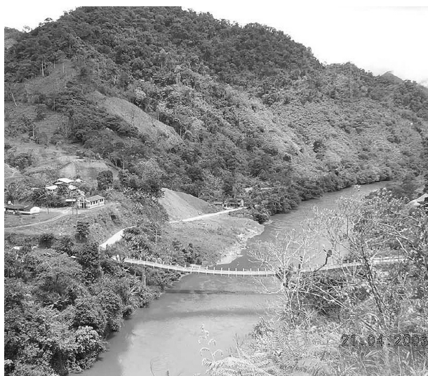
Inicio del nuevo puente.
