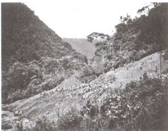
Una minga en la construcción de la vía férrea
