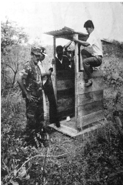
Soldados y civiles construyendo letrinas en un sector de la frontera orense.
