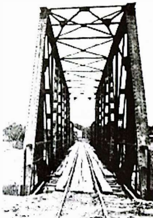
Puente del ferrocarril Puerto Bolívar-Loja, sobre el río Santa Rosa, a un kilómetro de la población del mismo nombre.
