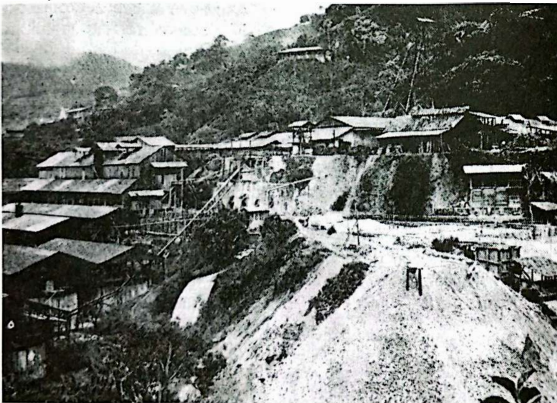
Sección de maquinarias y demás trabajos de la South American Development Co. Al fondo se ve claramente el Castillo por el cual se penetra a las galerías subterráneas.
