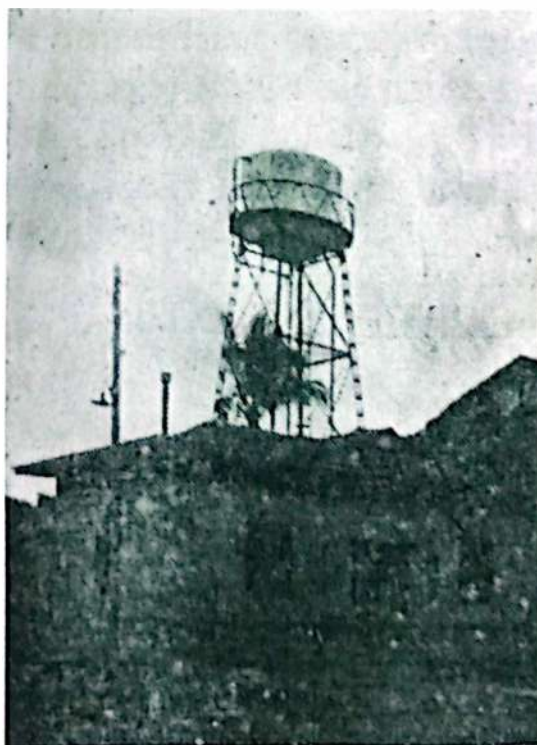
Planta de luz eléctrica y agua potable de Santa Rosa.
