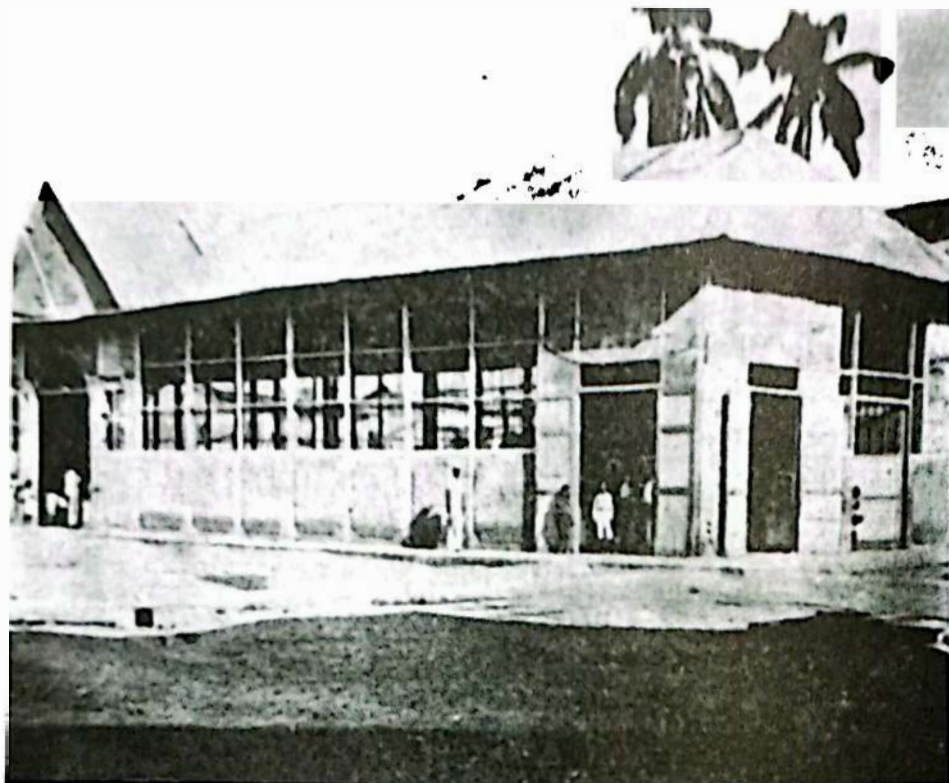
Machala-Plaza de Mercado, de reciente construcción.
