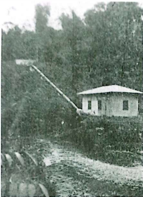
Planta Eléctrica en Casacay. Movida a fuerza hidráulica con las aguas del río Casacay, suministra luz a Pasaje, Machala y Puerto Bolívar.
