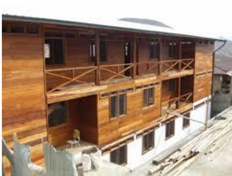
Edificio de la A.D.P. ya restaurado en 1914
